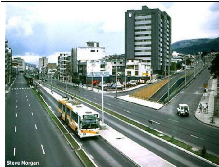
Photo 4 – First Stage Busway - Av 10 de Agosto - General Configuration
